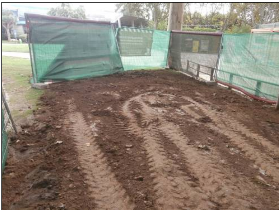
Fotografia 50: Finalització del rebliment de la Rasa 4-Sud.
