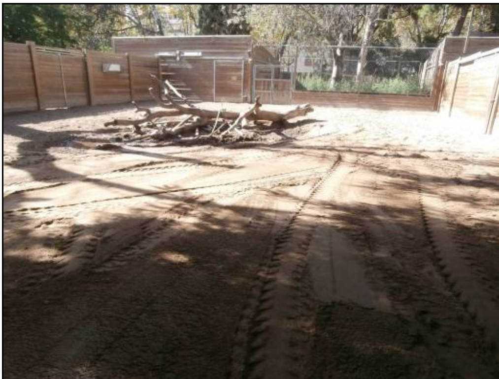
Fotografia 69: Finalització del rebliment de la Rasa 1-Nord.
