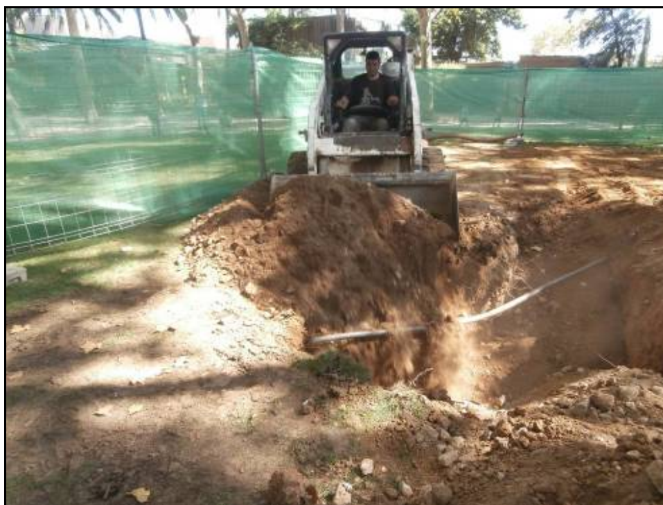
Fotografia 14: Rebliment de la Rasa 1-Sud.
