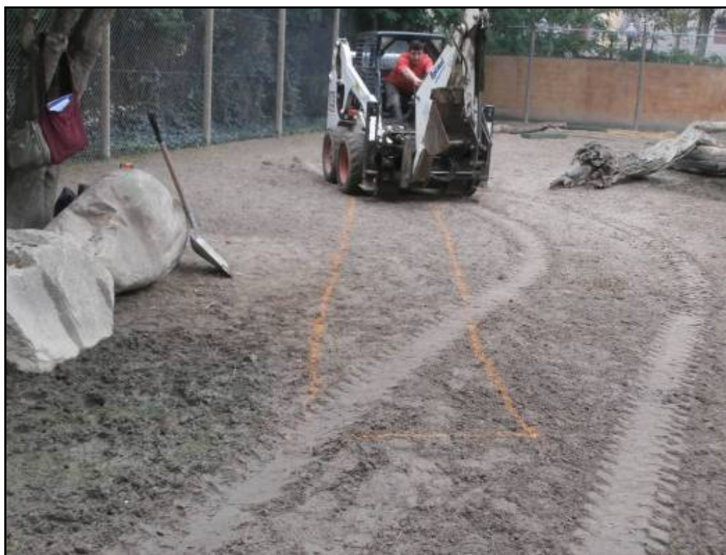
Fotografia 70: Espai de la Rasa 2-Nord.
