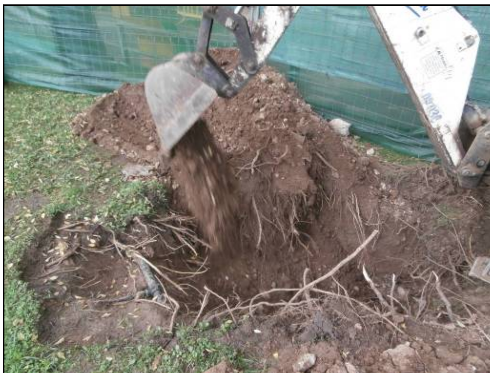
Fotografia 84: Rebliment de la Rasa 4-Nord.
