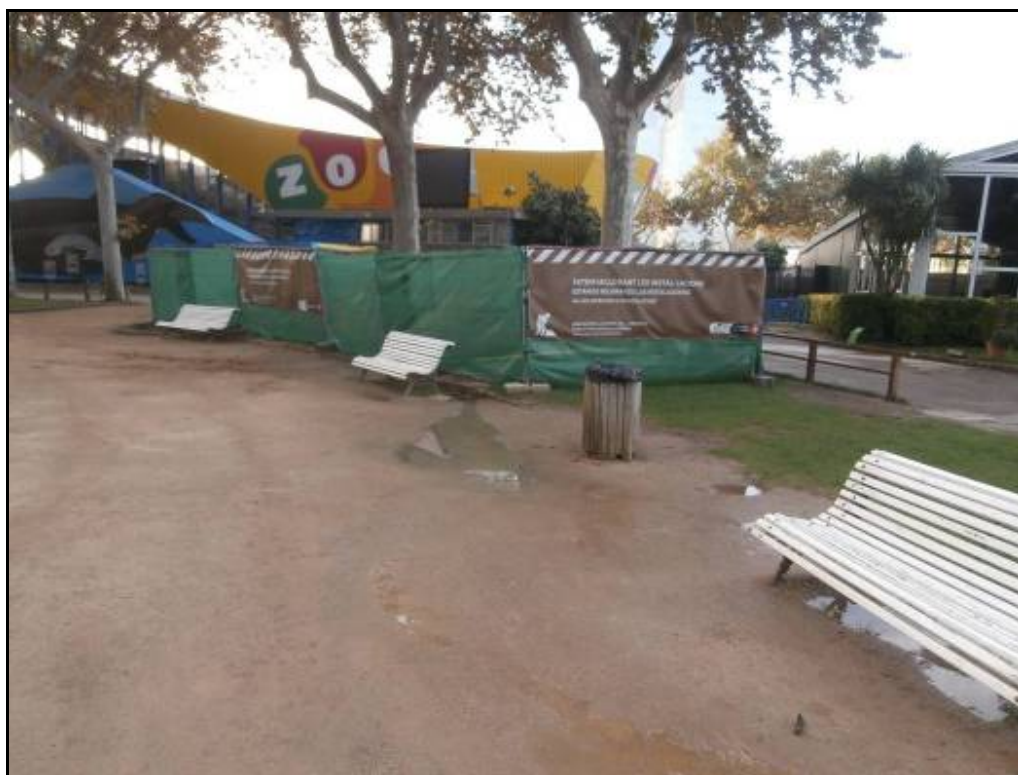
Fotografia 52: Tancat de la Rasa 5-Sud.
