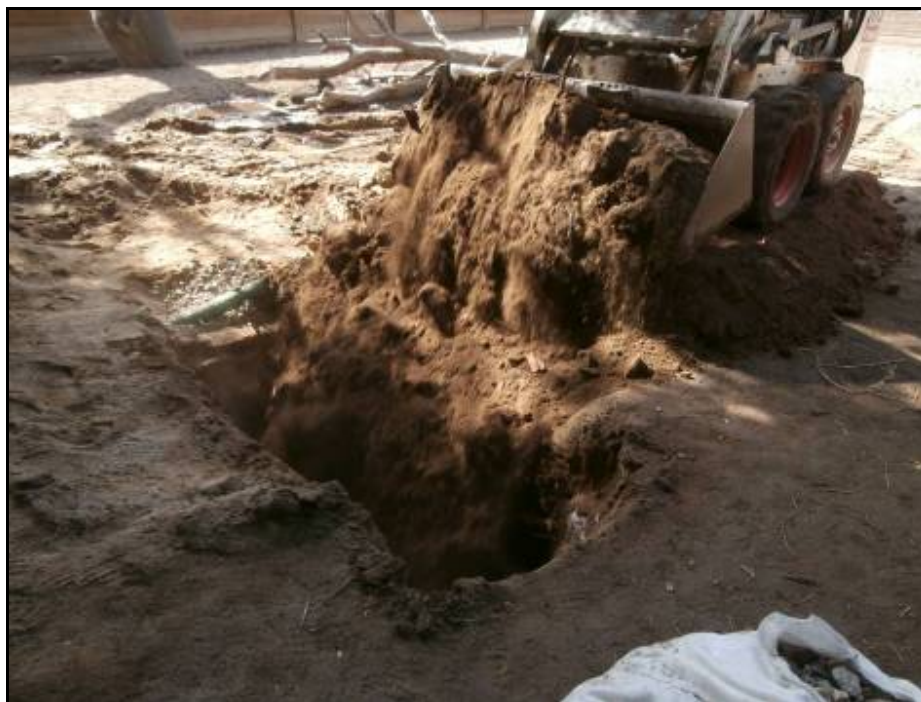
Fotografia 68: Rebliment de la Rasa 1-Nord.
