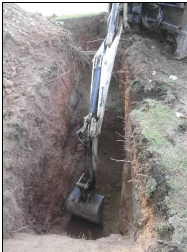
Fotografia 46: Rebaix a l'espai sense pavimentació, Rasa 4-Sud.
