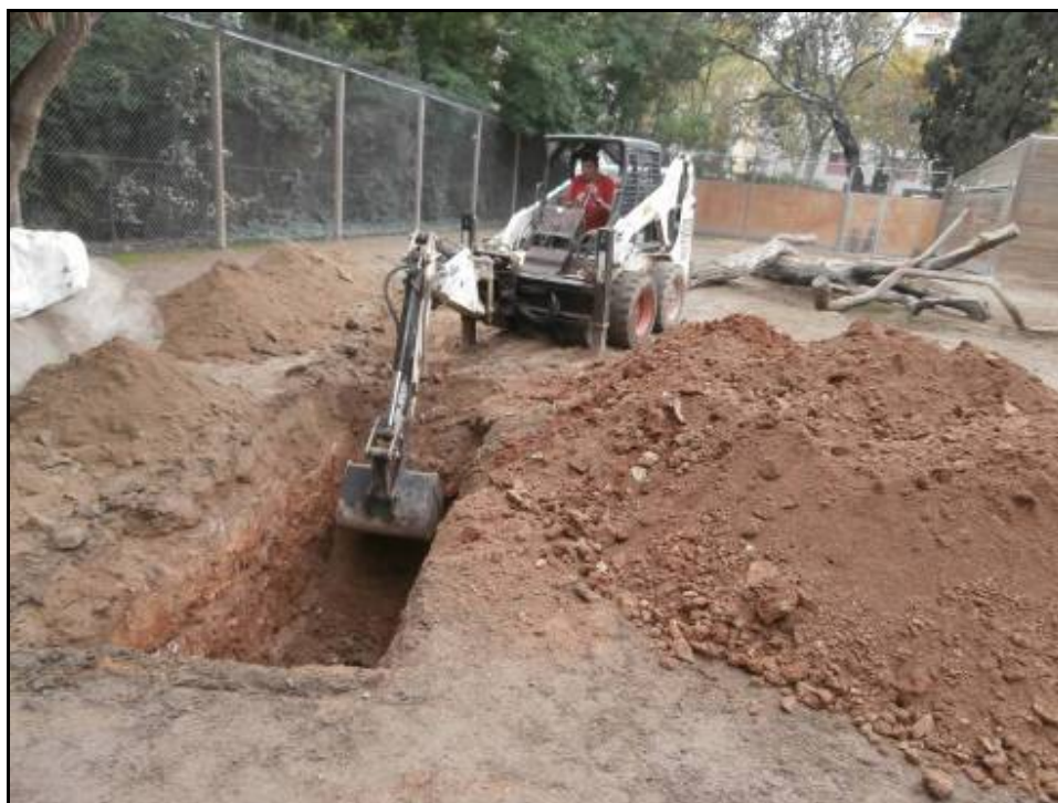
Fotografia 71: Excavació de la Rasa 2-Nord.
