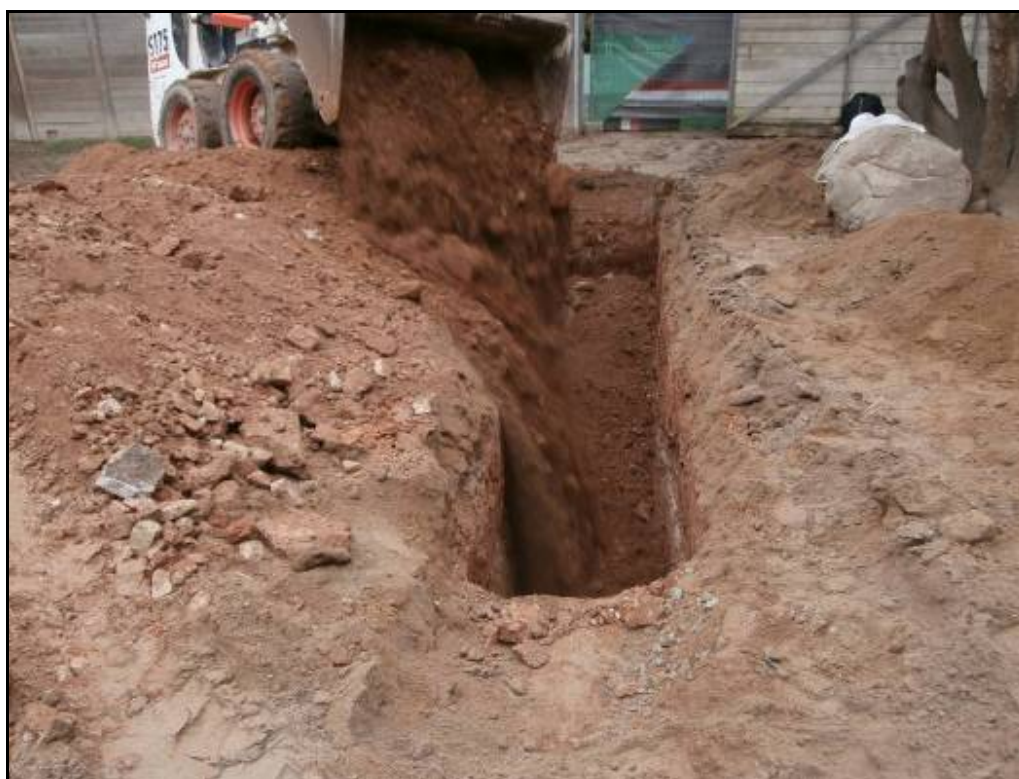
Fotografia 74: Rebliment de la Rasa 2-Nord.
