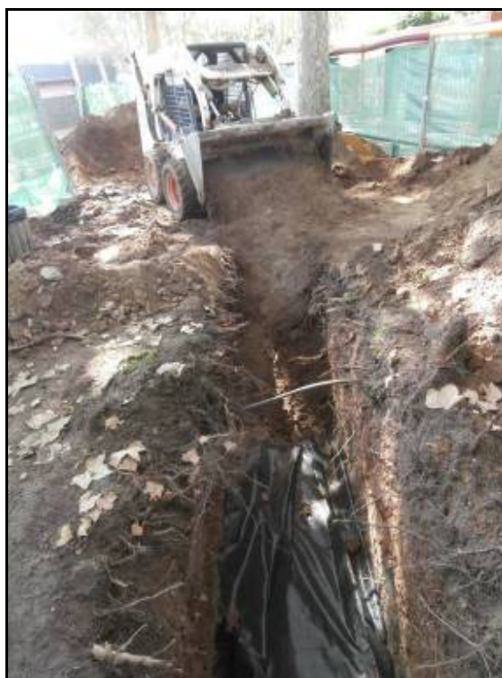
Fotografia 42: Rebliment de la Rasa 3-Sud.
