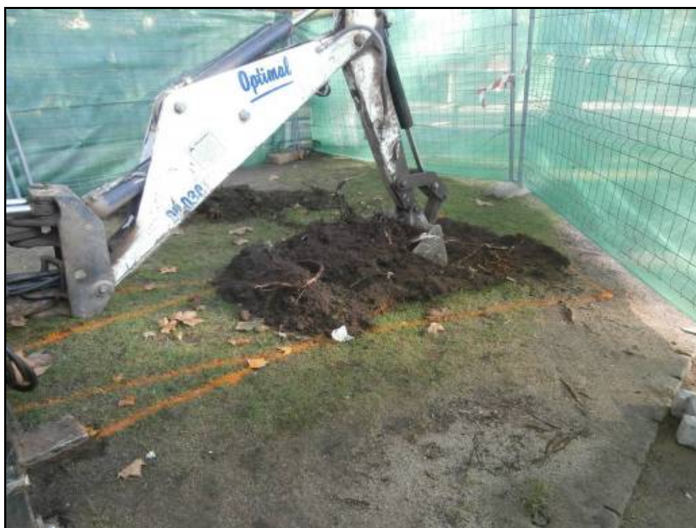
Fotografia 34: Inici dels treballs en Rasa 3-Sud.
