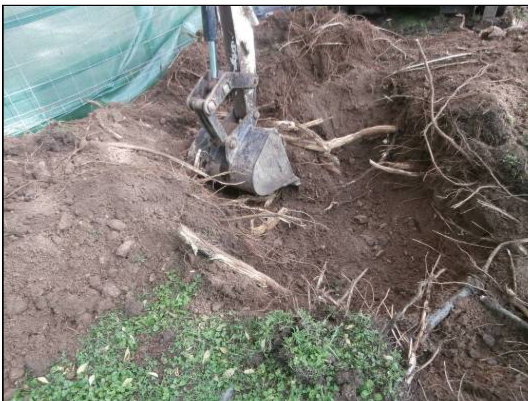
Fotografia 78: Excavació de la Rasa 4-Nord.
