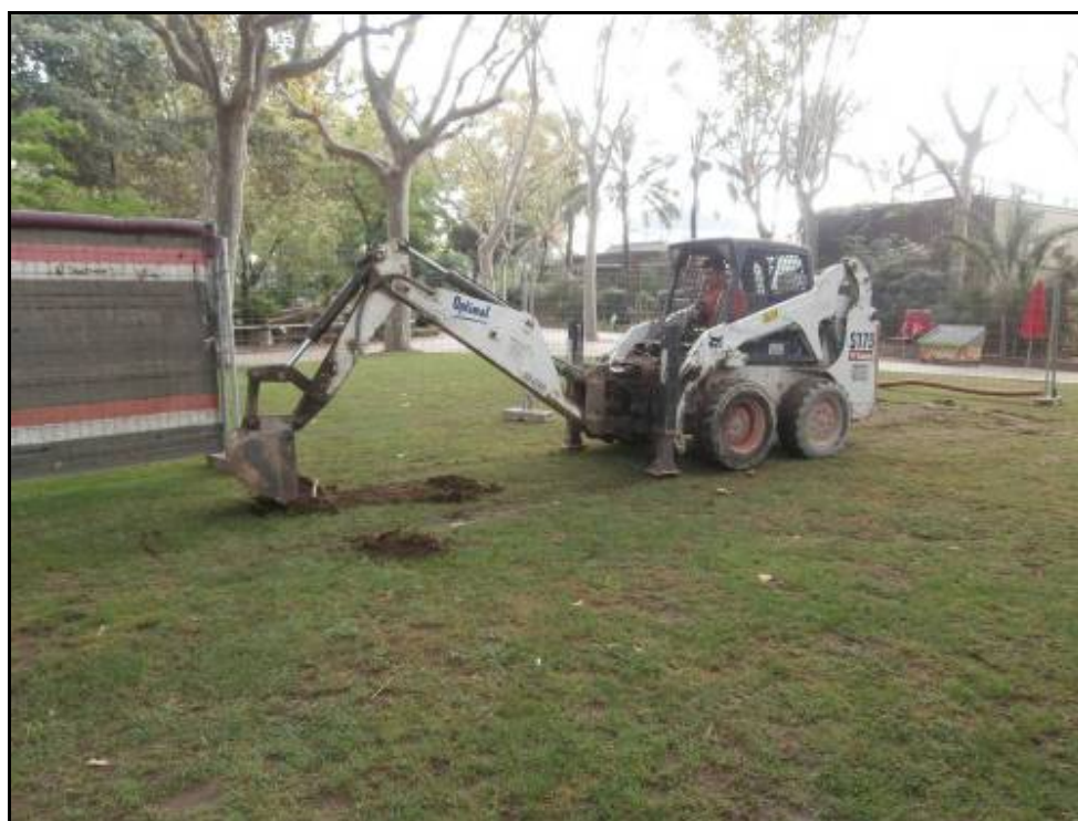
Fotografia 4: Inici dels treballs en Rasa 1-Sud amb BobCat retroexcavadora.
