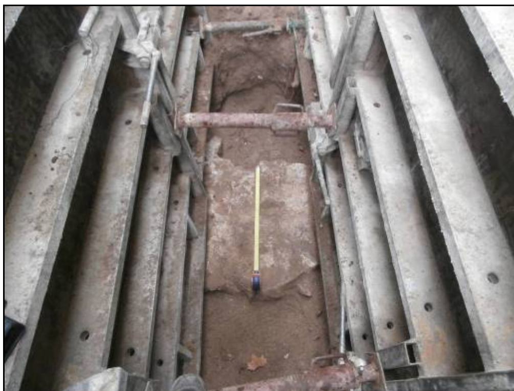
Fotografia 58: Vista zenital del mur UE 507 després de la neteja manual.
