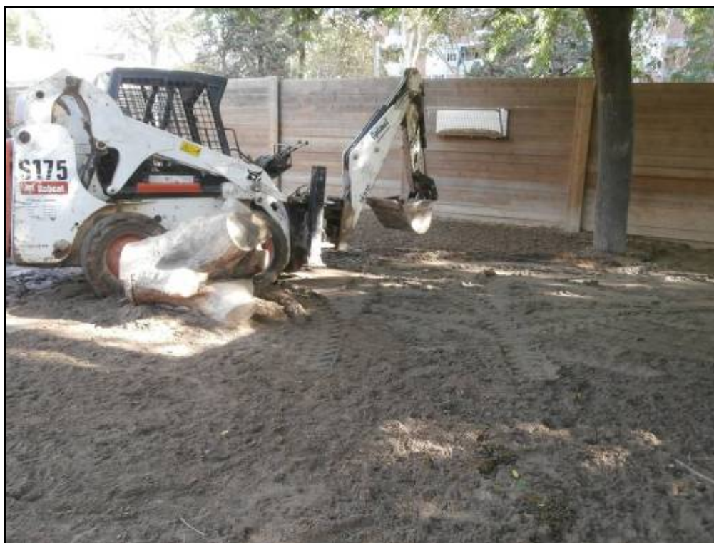
Fotografia 61: Espai de la Rasa 1-Nord.
