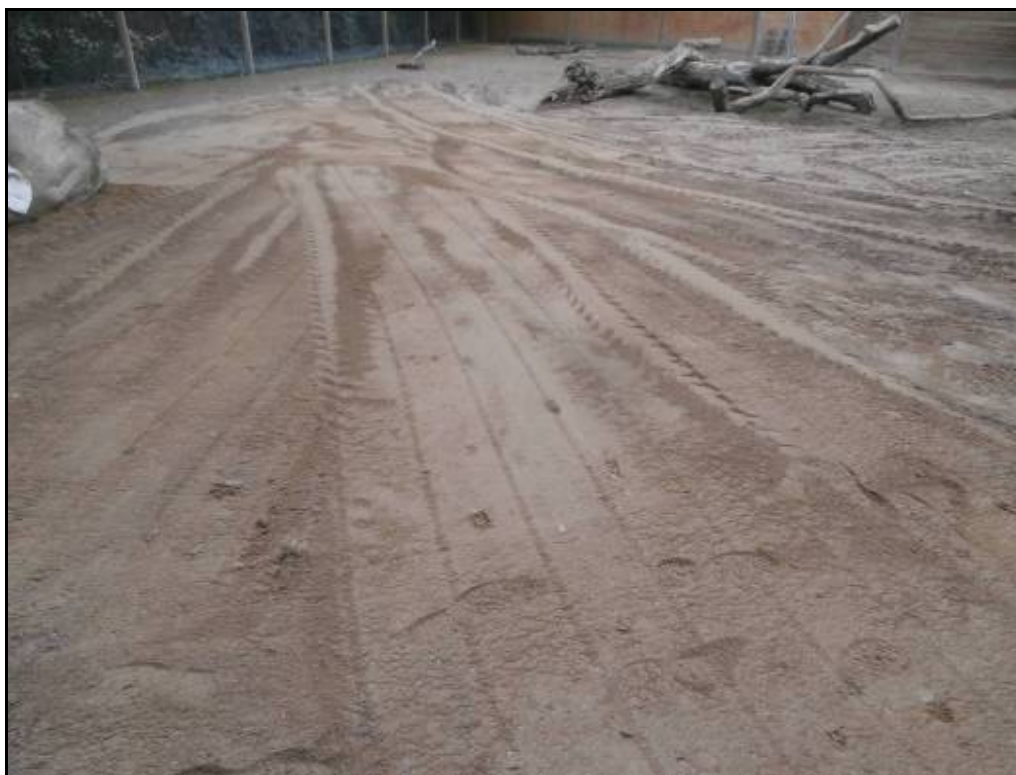
Fotografia 75: Finalització dels treballs a la Rasa 2-Nord.
