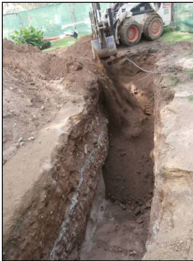
Fotografia 31: Rebliment de la Rasa 2-Sud.
