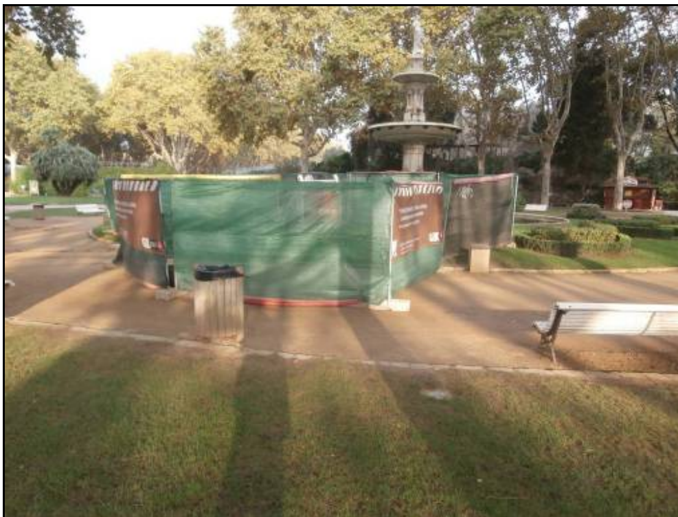
Fotografia 17: Tancat de la Rasa 2-Sud.
