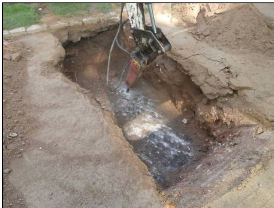
Fotografia 20: Trencament amb martell pneumàtic del paviment UE 202, Rasa 2-Sud.
