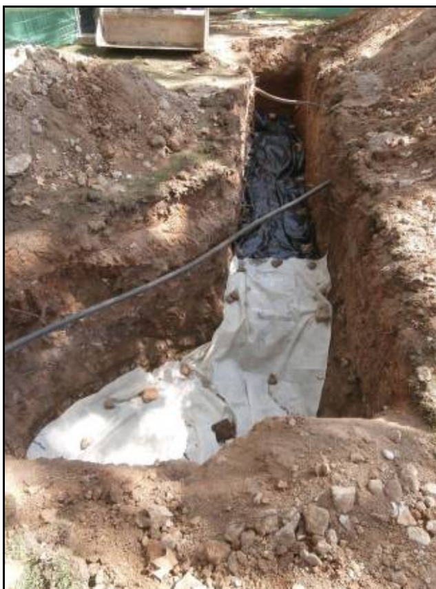
Fotografia 13: Protecció amb geotèxtil de les estructures de la Rasa 1-Sud.
