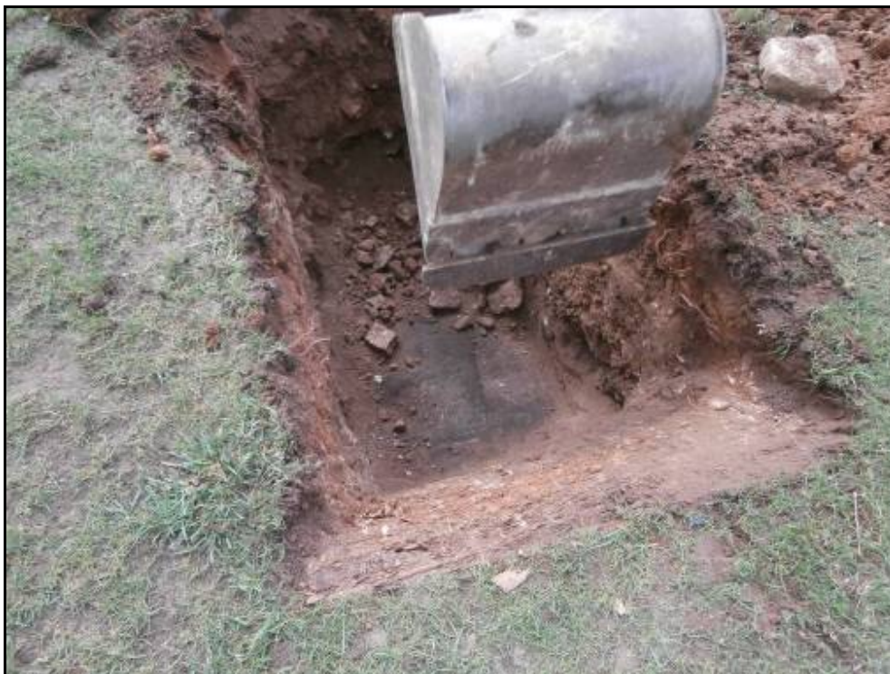
Fotografia 5: Troballa del paviment UE 103.
