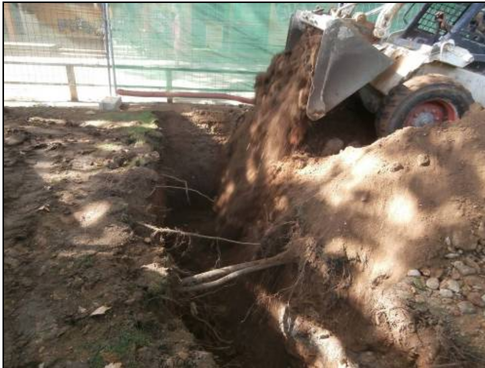
Fotografia 49: Rebliment de la Rasa 4-Sud.
