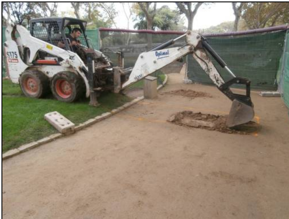
Fotografia 18: Inici dels treballs a la Rasa 2-Sud.
