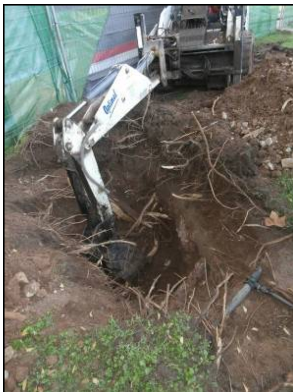
Fotografia 83: Excavació final de la Rasa 4-Nord.
